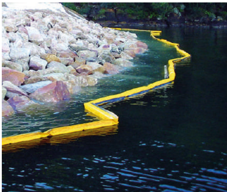
удерживающие боны (для задержания разлившихся нефтепродуктов) localization boom (for oil spill localization) локализациони бум за задржавање нафте
