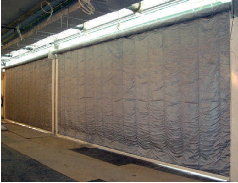
противопожарные шторы fire-resisting shutters противопожарне завесе
